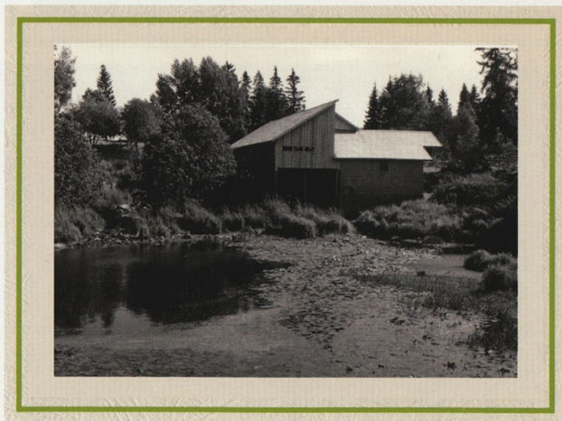
Myllyrakennus alajuoksulta päin kuvattuna. Oikealla vuonna 1917 valmistunut myllyrakennus. Vasemmalle puolelle jää ”turbiinihuone”, jonne vesi johdettiin patoaltaasta rännin kautta. Turbiinimyllyt syrjäyttivät tehokkuutensa ansiosta ratasmyllyt 1800-luvun lopulla ja 1900-luvun alussa. Kuva: Loimaan kaupungin arkisto, Ari Anttilan kokoelma
